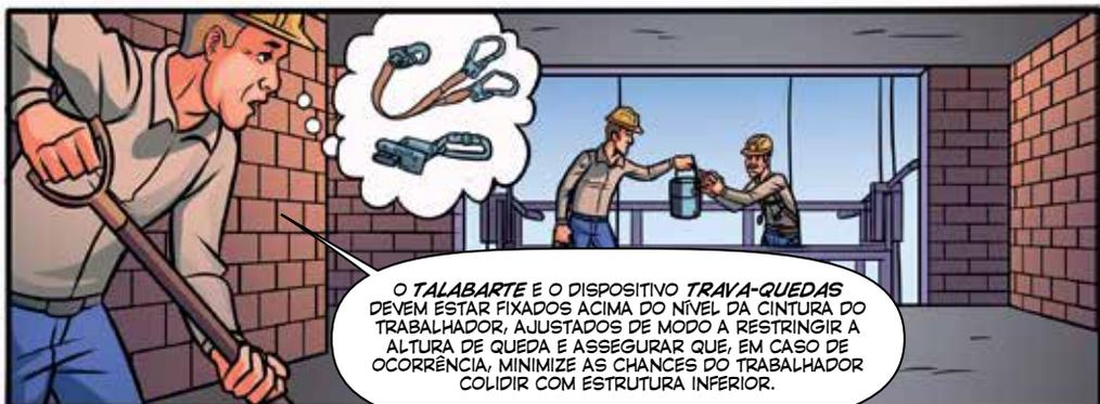
O TALABARTE E O DISPOSITIVO TRAVA-QUEDAS DEVEM ESTAR FIXADOS ACIMA DO NÍVEL DA CINTURA DO TRABALHADOR, AJUSTADOS DE MODO A RESTRINGIR A ALTURA DE QUEDA E ASSEGURAR QUE, EM CASO DE OCORRÊNCIA, MINIMIZE AS CHANCES DO TRABALHADOR COLIDIR COM ESTRUTURA INFERIOR.
